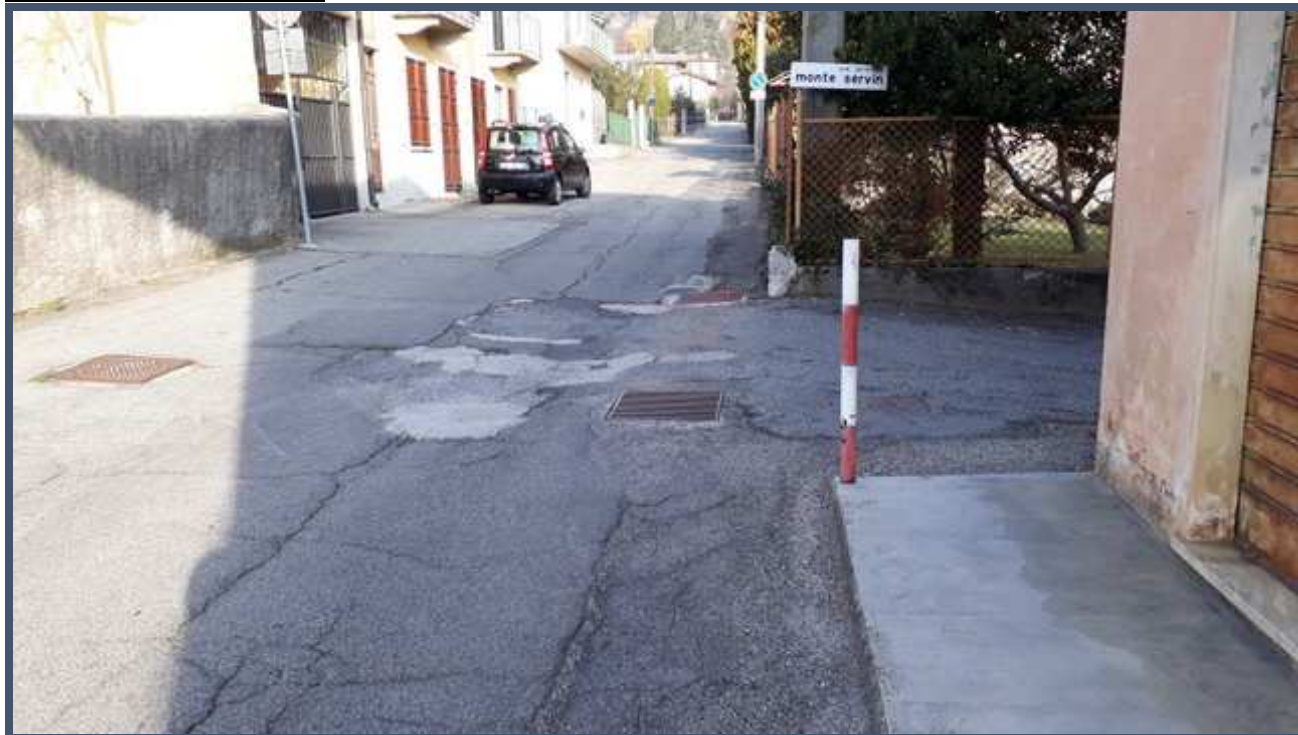
Str. Del Baussan (2 di 4)
