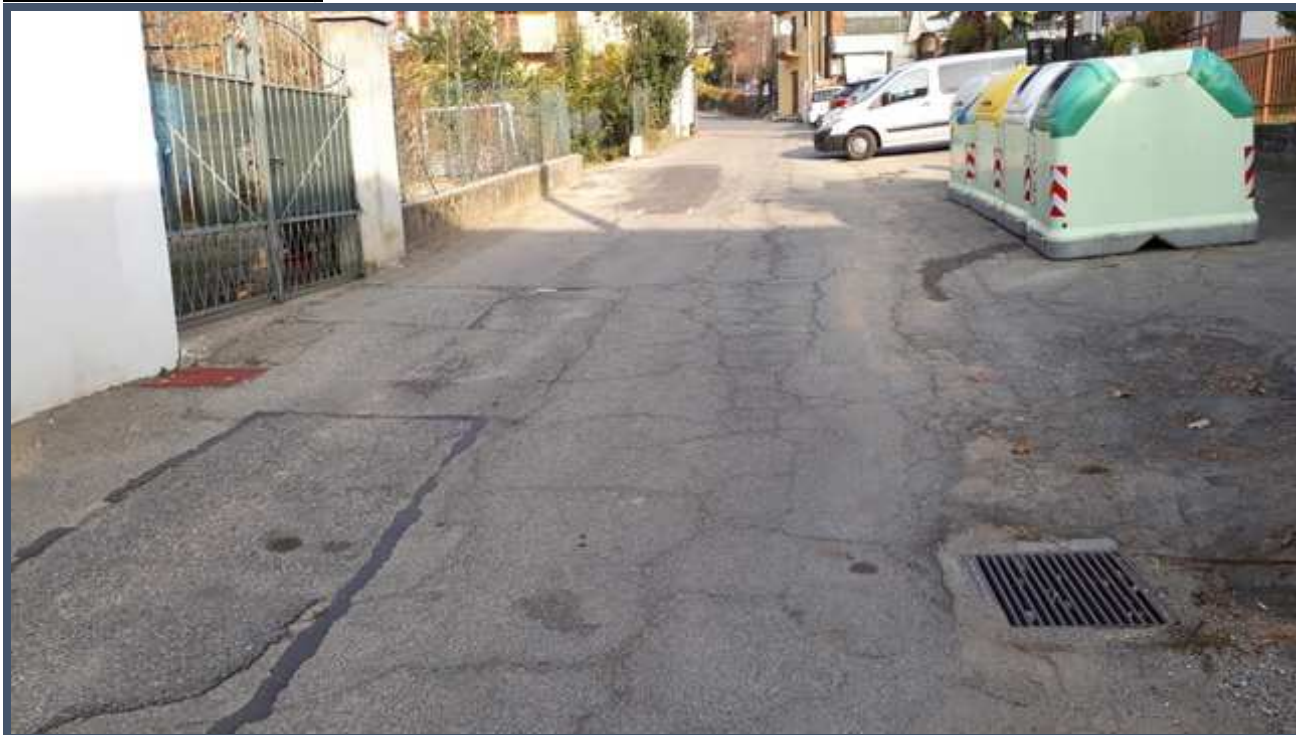
Str. Del Baussan (4 di 4)
