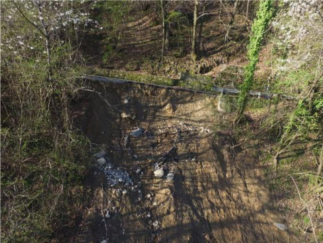
Figura 1: Versante franato – coronamento.
