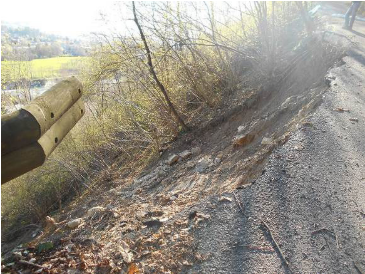
Vista da monte, ovvero dalla strada Comunale Via Inverso Colletto, dell'area in frana ai piedi della medesima strada Comunale.
