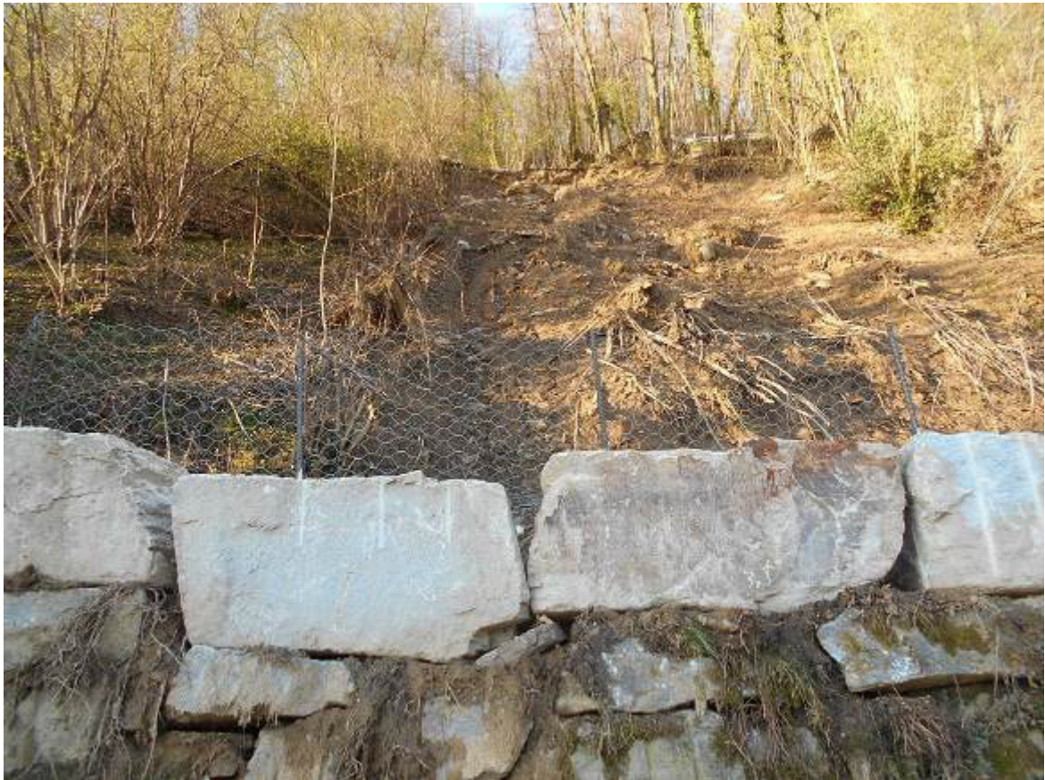
Vista da valle, ovvero dalla strada Comunale Via Fonte Bianco, dell'area in frana ai piedi della strada Comunale Via Inverso Colletto.
