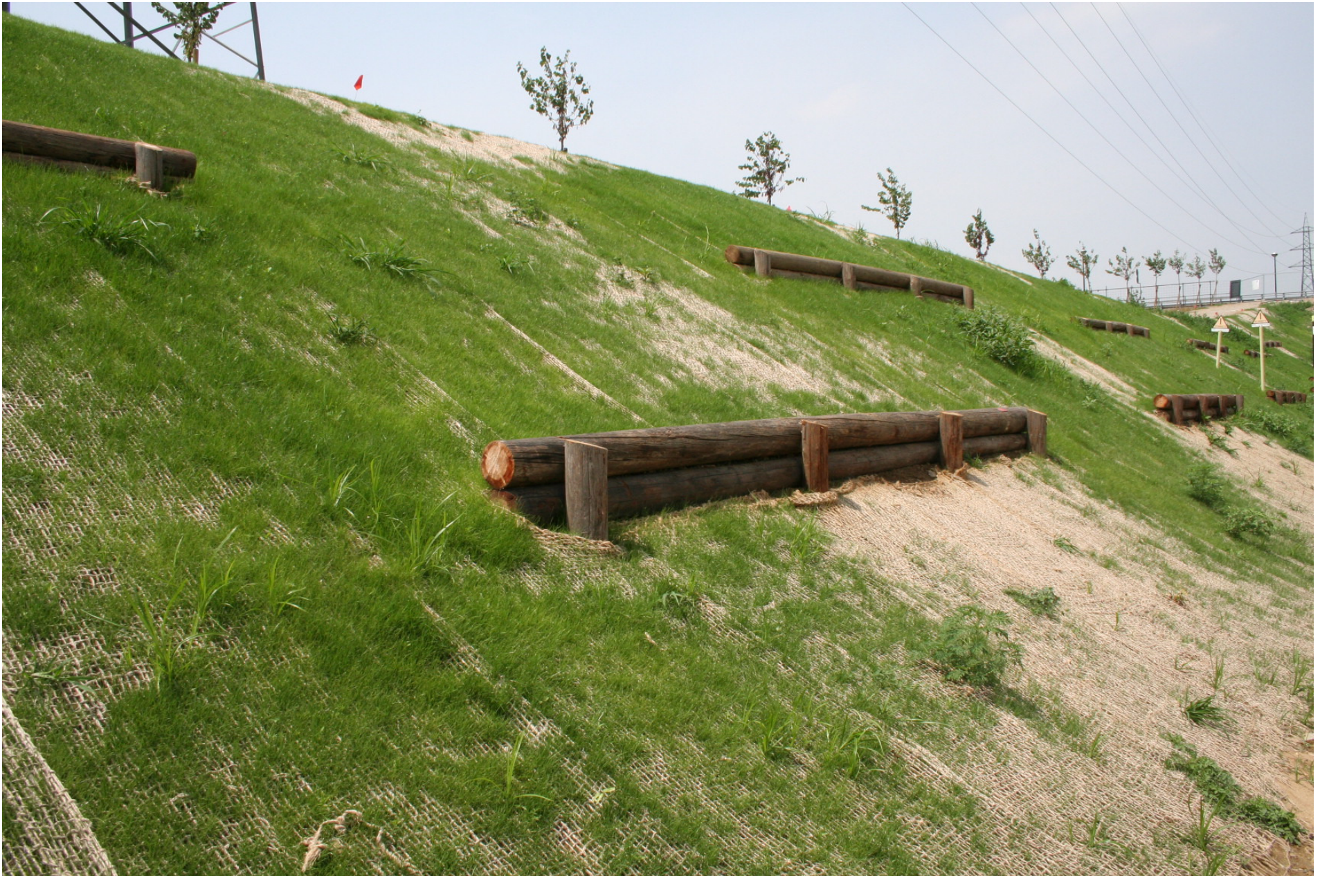
Figura 18 SISTEMAZIONE DI FRONTE SCARPATO CON PALIZZATE SEMPLICI E GEOJUTA.
