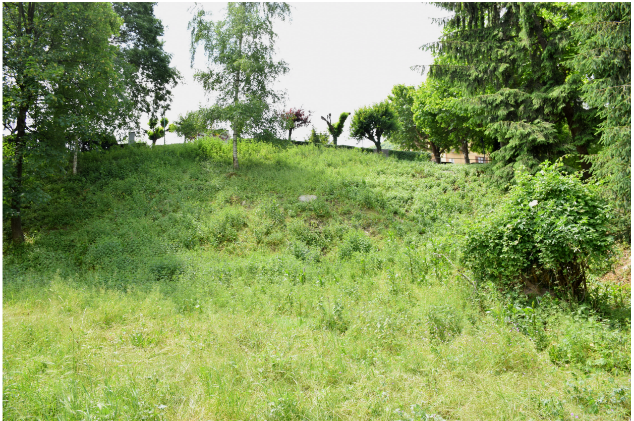
Figura 7 VISTA DELLA SCARPATA A MONTE (SUD) DELLA PIAZZALE/PARCHEGGIO. RIPRESA FOTOGRAFICA DAL SENTIERO CICLO-PEDONALE.
