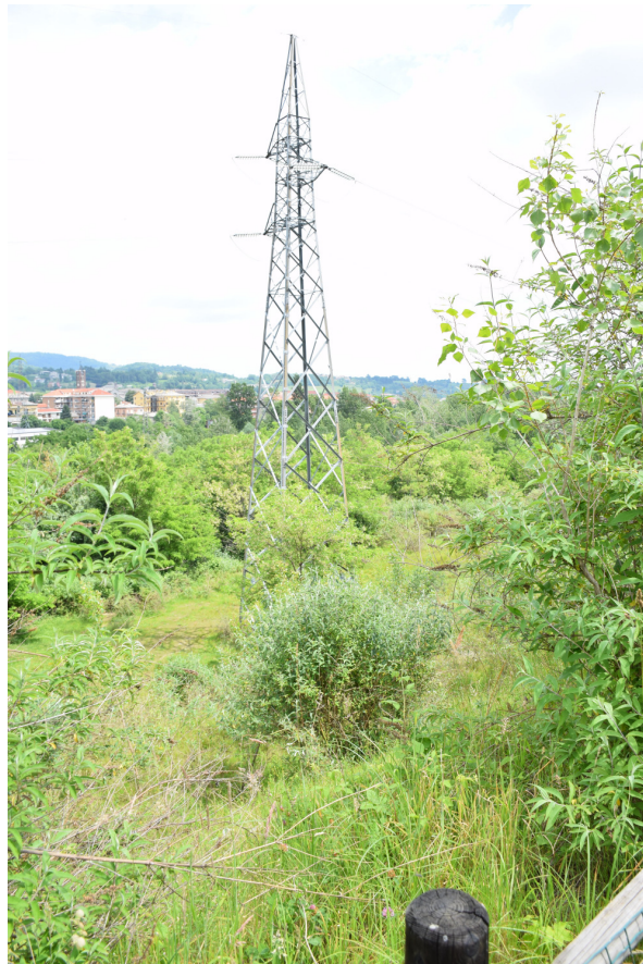
Figura 12 VISTA DELLA CONDIZIONE VEGETATIVA DELLE SCARPATE SITE A NORD E PARTICOLARE DEL TRALICCIO 'ENEL'. RIPRESA FOTOGRAFICA DAL PIAZZALE/PARCHEGGIO.
