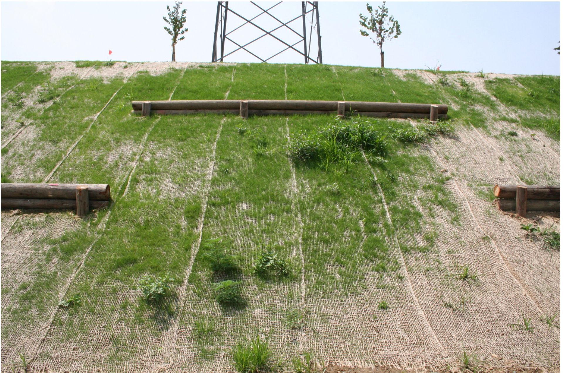
Figura 19 SISTEMAZIONE DI FRONTE SCARPATO CON PALIZZATE SEMPLICI E GEOJUTA.
