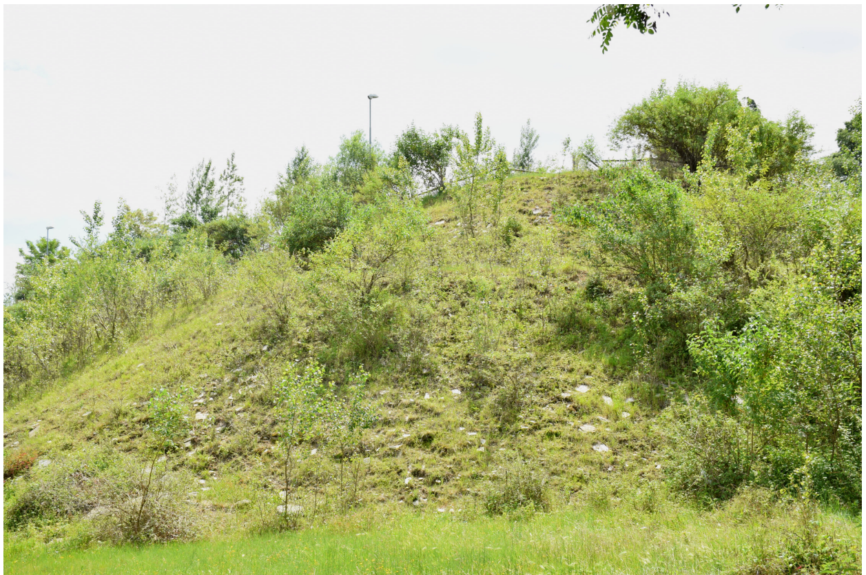
Figura 6 VISTA DELLA SCARPATA SITA A NORD DELLA PIAZZALE/PARCHEGGIO. RIPRESA FOTOGRAFICA DAL SECONDO PIANORO FORMATO A VALLE DELLA SUDETTA PIAZZOLA.
