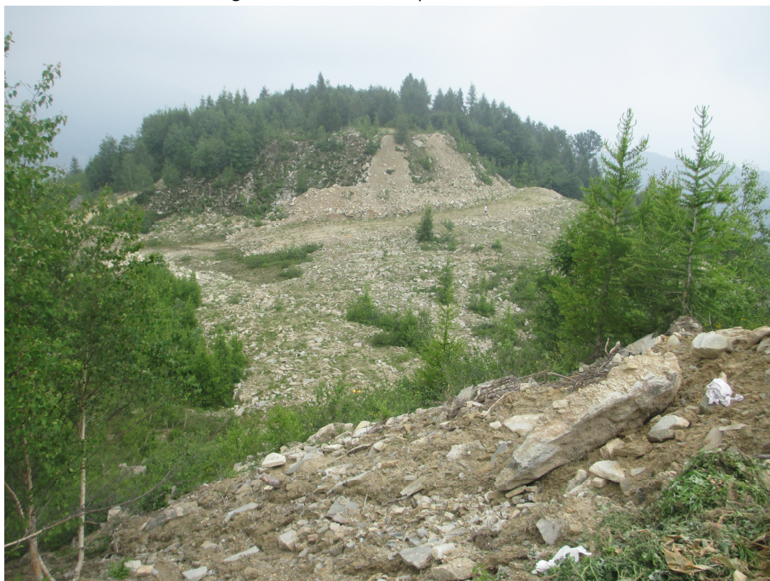
Fig.15 – Panoramica della località "Sea-Lotti 11 e 12"
