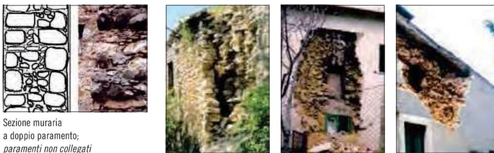
Fig. 3.2 – Ps: sezione a paramenti con elementi scollegati o male ammassati come evidenziato da crolli rovinosi provocati dal sisma
