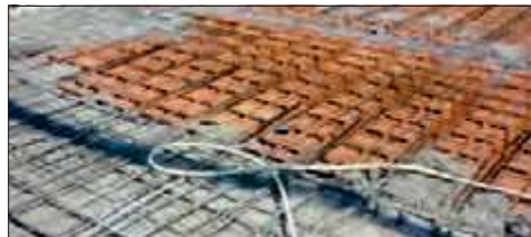
Solaio in laterocemento gettato in opera
