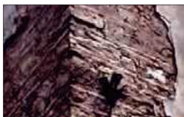
Muratura di pietrame con ricorsi laterizi
