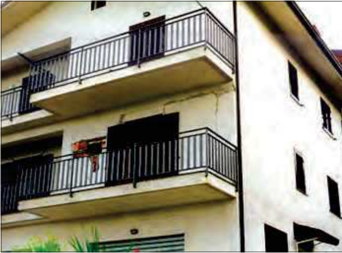
Figura 4.32 Lesioni orizzontali e verticali alla tamponatura, per distacco dalla struttura principale; crollo parziale della tamponatura fra le due porte. Livello del danno alle tamponature: diffuso D2/D3, localmente D4.
