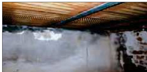
Solaio in putrelle e tavelloni
